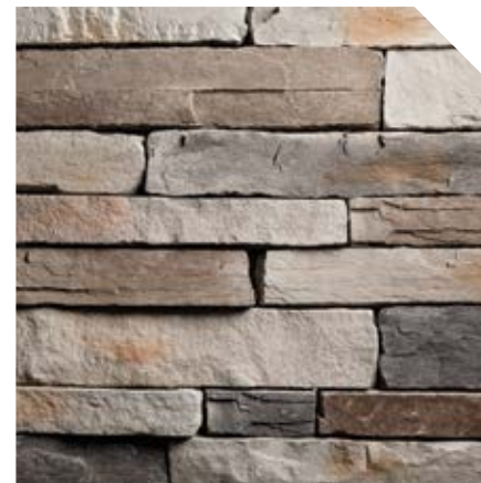
Sans joint de mortier
